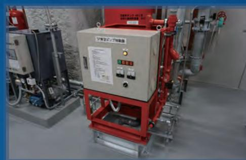
SP真空ポンプは、強力な吸引力により、バルブ操作だけで簡単に配管の水抜き作業が終了するため、大幅な人員削減と作業時間の短縮が可能となり、維持管理コストを大幅に低減できます。
